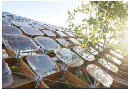
صورة (2) السقف المموج فوق هيكل شبكي مفتوح واستخدام لوحات لتوليد الطاقة الكهربائية
