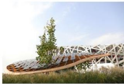
صورة (2) السقف المموج فوق هيكل شبكي مفتوح واستخدام لوحات لتوليد الطاقة الكهربائية
